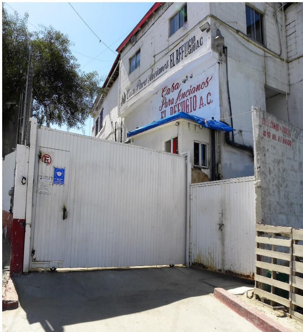
Fachada de entrada a la "Casa para Personas Mayores El Refugio" A.C.
