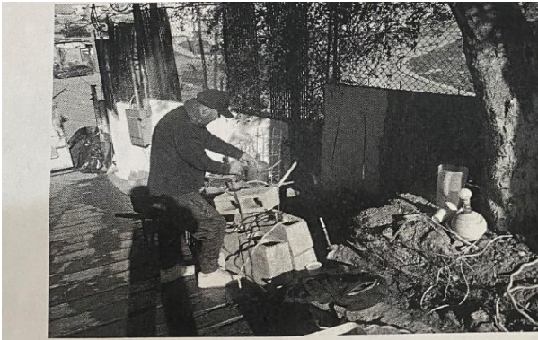
Se esta remodelando la entrada de la institucion haciendole jardineras.
