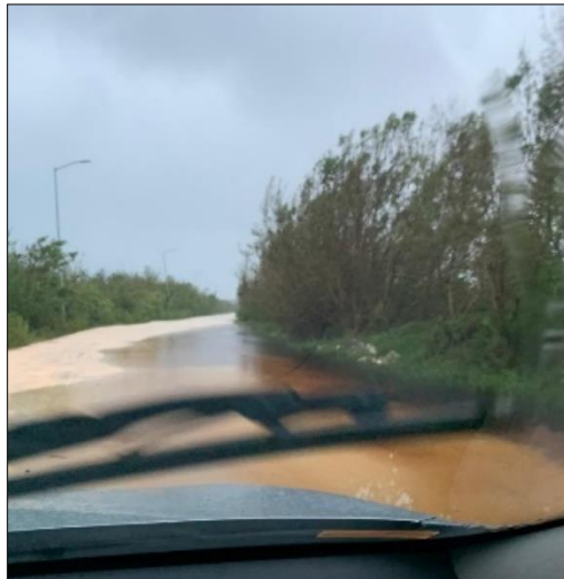
Imagen 1: Camino de acceso inundado
