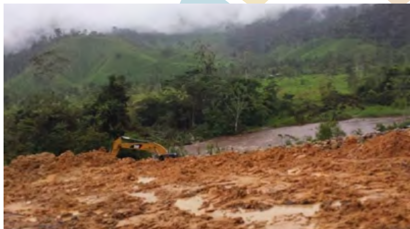
Labores de construcción de la empresa china ECSA. Foto: Comunidad Amazónica de Acción Social Cordillera del Cóndor Mirador (CASCOMI).
