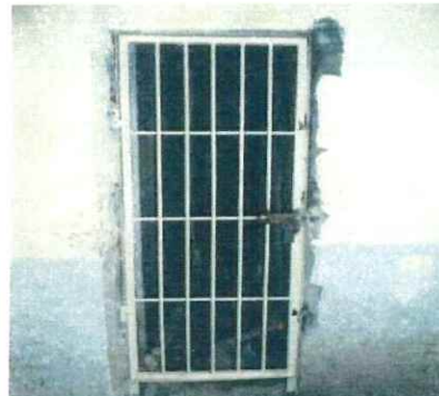
REPARACIÓN DE REJAS
