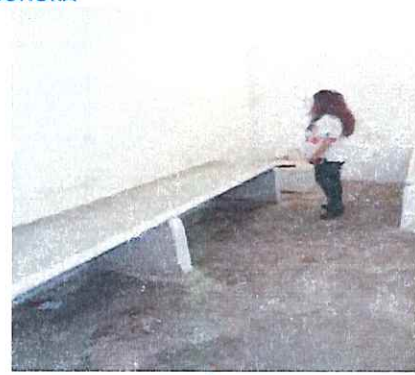
CONSTRUCCIÓN DE PLANCHAS.
