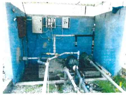
MANTENIMIENTO DE TUBERÍA
