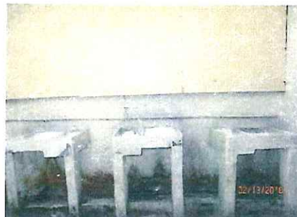
REPARACIÓN Y PINTURA DE LAVADEROS
