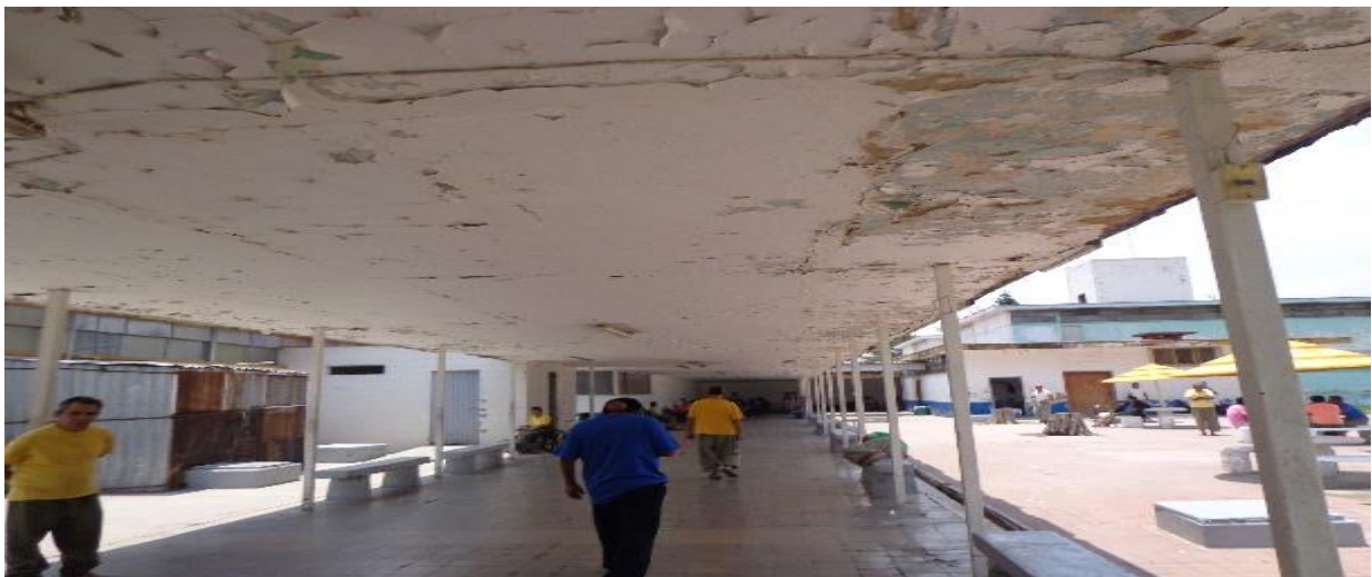
Entrada al dormitorio varonil, Hospital Psiquiátrico "CAISAME", Estancia Prolongada en Tlajomulco, Jalisco
