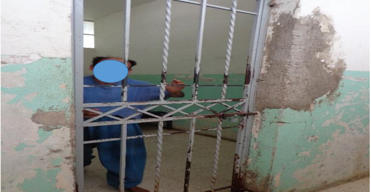
Aislado, Hospital Psiquiátrico "CAISAME", Estancia Prolongada en Tlajomulco, Jalisco
