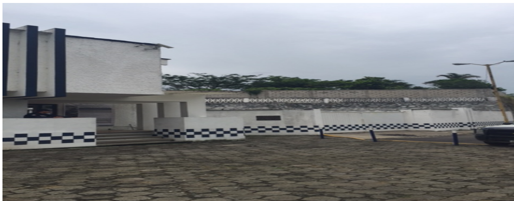
Entrada a las instalaciones de Seguridad Pública
